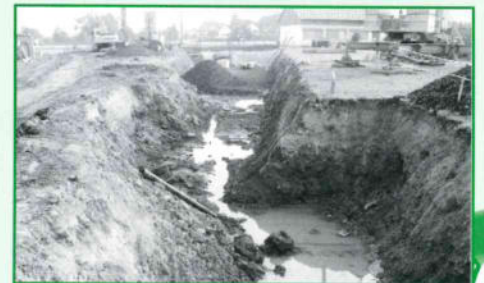
Ausbaggerung der Schießbahn mit Kugelfang vom 8. Oktober
