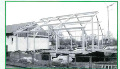
Das Grundgerüst steht – 16.2.06
