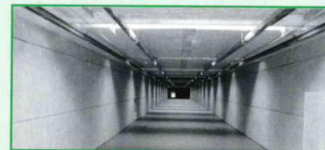
So sieht der fertige Schießstand aus. 14.4.2007
