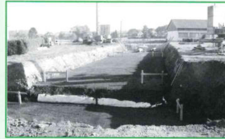
Die Schießbahn wurde geschottert.
